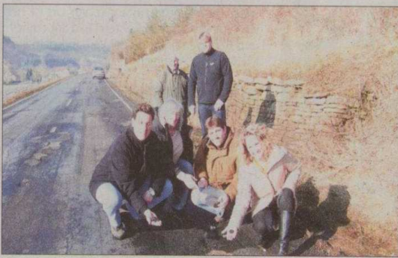
Straßenschäden werden auf 1.900 qm repariert Bericht und Bilder: Albrecht Wolff
